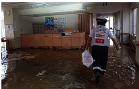
4) 泥に埋もれる被災病院1階
